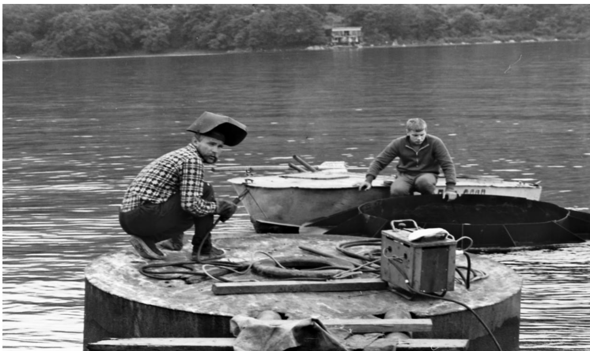
В. Шевелев и В. Тягельский на строительстве моста
